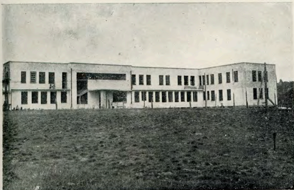
Hospital Municipal em construção. Face Central.
