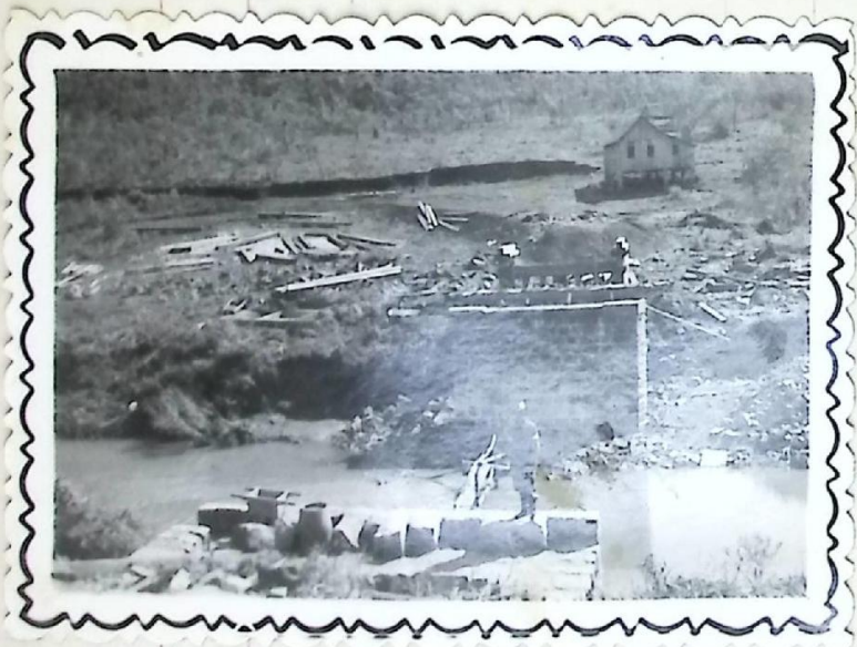
Construção da Ponte do L. Grande. Saraceli
