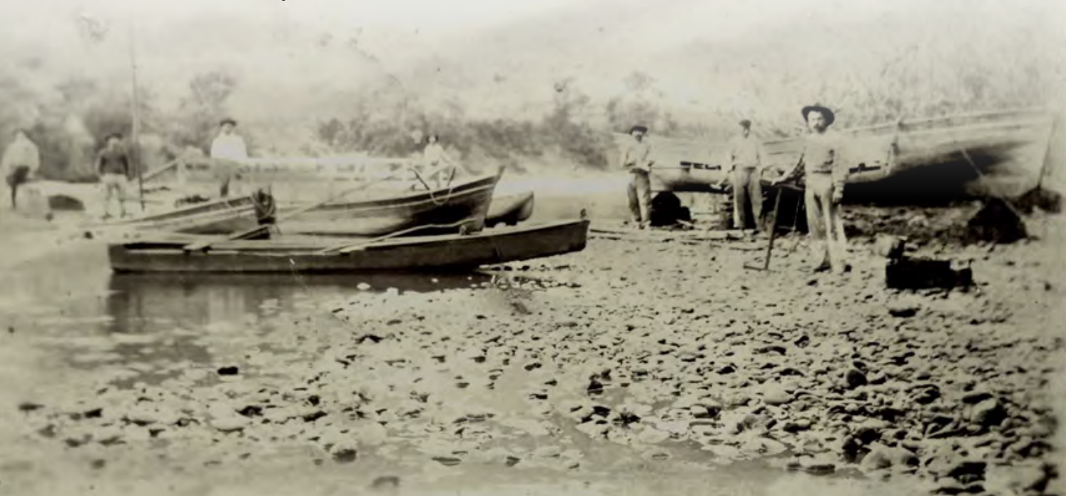
FIGURA 3. Registro de “gasolinas” no Porto de Muçum (s.d.). Pequenas “gasolinas” utilizadas na barqueação para o transporte de carga no Porto de Muçum na época de águas baixas. Fonte: Arquivo Histórico do Município de Muçum - Pe. Lucchino Vieiro Muçum.
