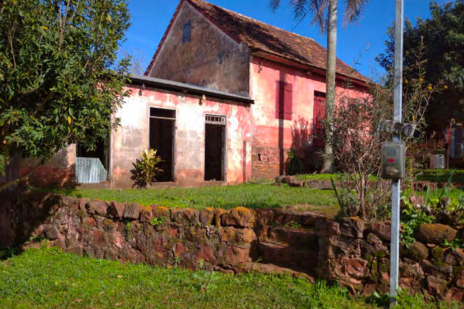
FIGURA 4. Construção em estilo italiano na Comunidade São Marcos. Fonte: Martins, 2020, p. 33.
