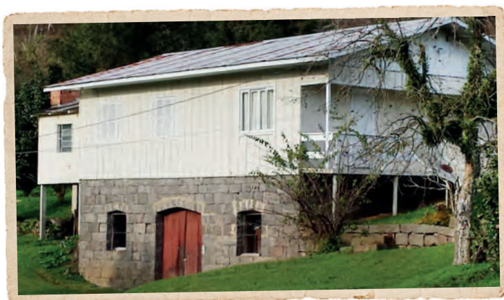
Porão de pedra da ex-casa de Biaggio Tomasini-2015
