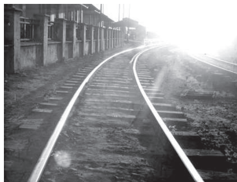
Av. 7 de Setembro, 1968 – Trilhos e casas dos ferroviários
