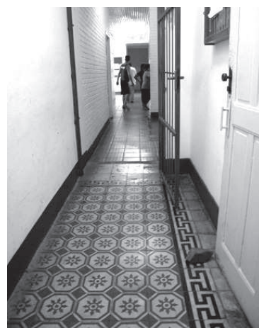
Piso em ladrilho hidráulico do Quartel do Exército “atualizado” pela substituição por lajotas coloniais. Fonte: Nino Machado
