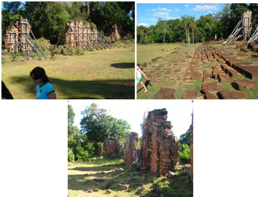
Paredes da Igreja de Santa Ana
