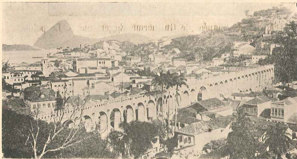
Viaducto — Rio de Janeiro.
