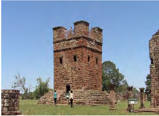
Ruínas de Trinidad – Torre
