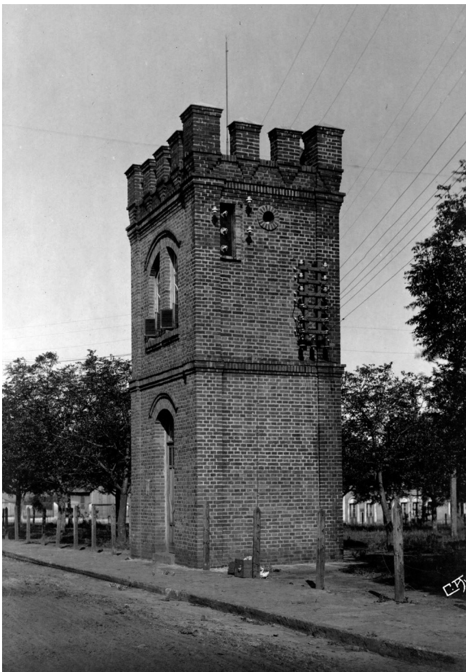
Transformador instalado na Praça Marechal Floriano, década de 1910.
