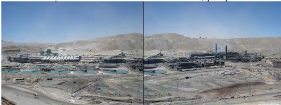
em tanques d'água
