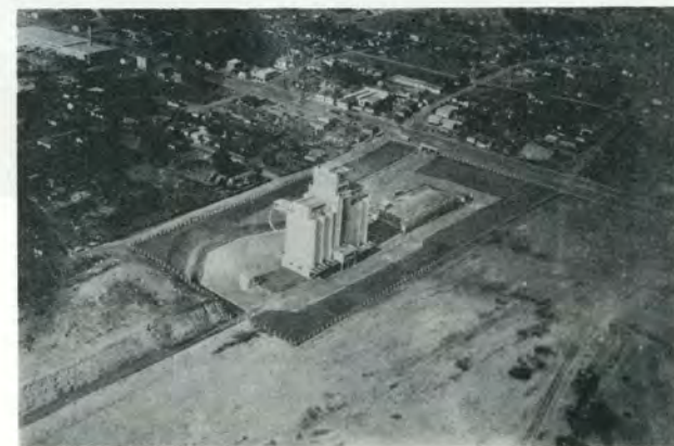
SILO DA CESA
