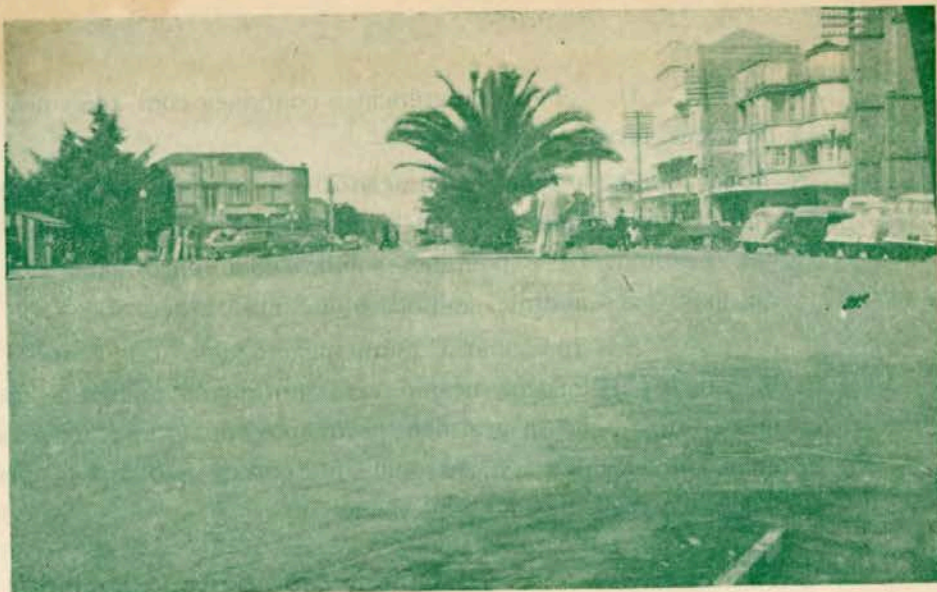
ASFALTO, AO FINAL, AV. GAL. NETO
