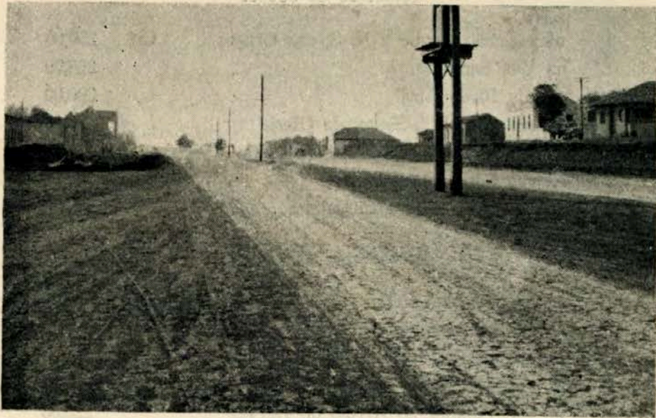
SERVIÇO DE TERRAPLANAGEM, NO BOQUEIRÃO
