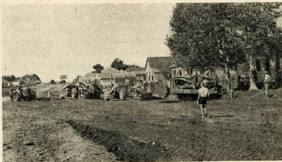
SERVIÇO DE TERRAPLANAGEM NO BOQUEIRÃO
