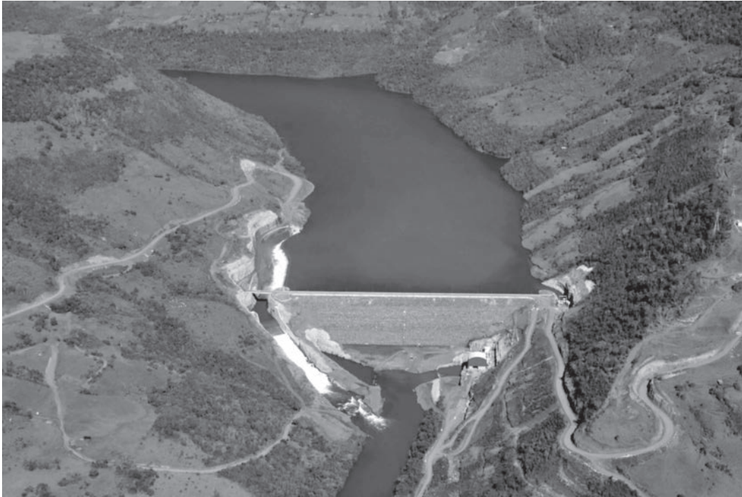
Figura 3 - Hidrelétrica do Monjolinho
