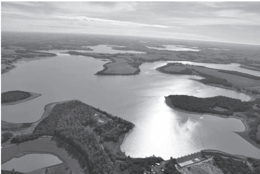
Figura 2 - Usina Hidrelétrica Passo Fundo
