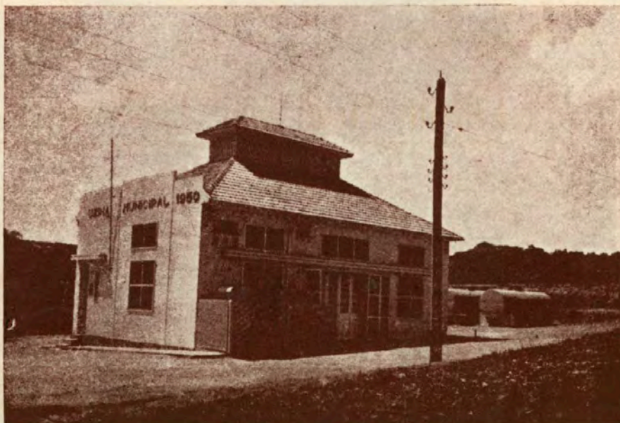
Casa de Máquinas
