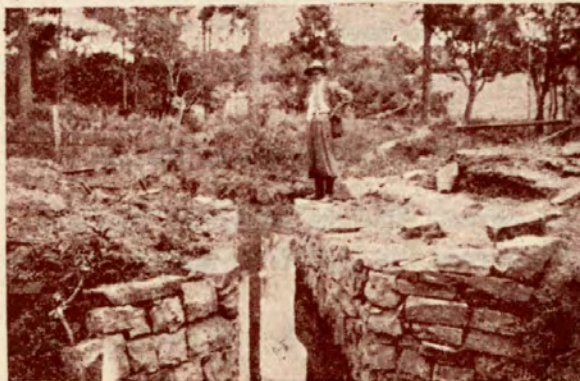
Outra vista do Pontilhão de pedra na estrada Marau-Tapera
