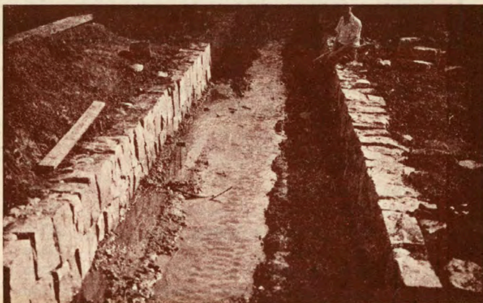
Pontilhão de pedras construído em janeiro de 1950, à rua Onze de Julho, em Vila Tapejara, medindo 15 metros de comprimento
