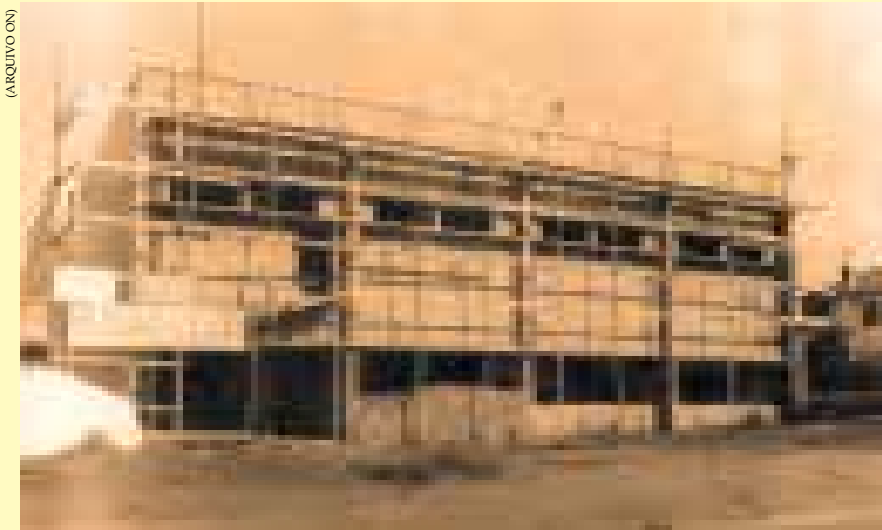
Construção do prédio da Faculdade de Filosofia
