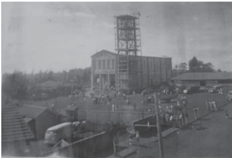
Fig. 4 Construção da Matriz da Paróquia São José Fotografia: autor desconhecido
