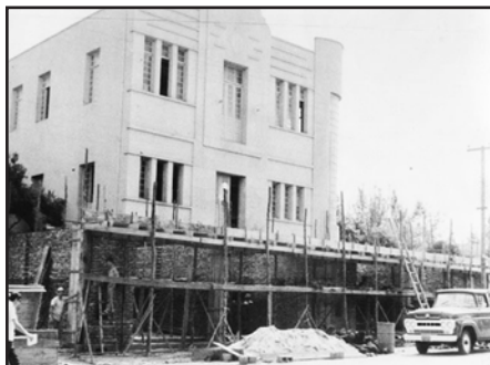
Foto: Clube 29 de julho em construção.
