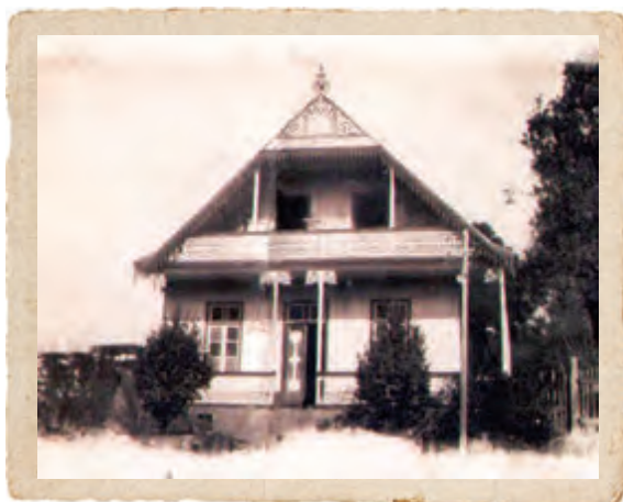
Casa de João Tomasini, neto de Adamo Tomasini, no município de Ilópolis/RS. A base era de pedra, com amplo porão para as pipas de vinho, com paredes triplas para minimizar o frio do inverno (1960).
