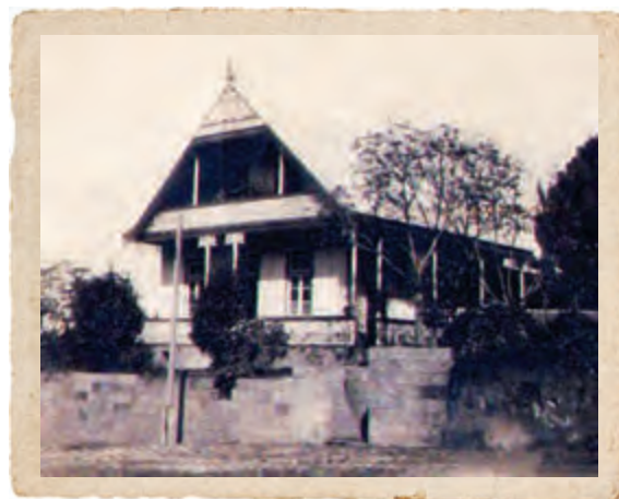
Casa de João Tomasini, neto de Adamo Tomasini, no município de Ilópolis/RS. A base era de pedra, com amplo porão para as pipas de vinho, com paredes triplas para minimizar o frio do inverno (1960).
