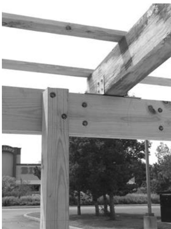
Figura 7 – amarração da estrutura wood Frame.
