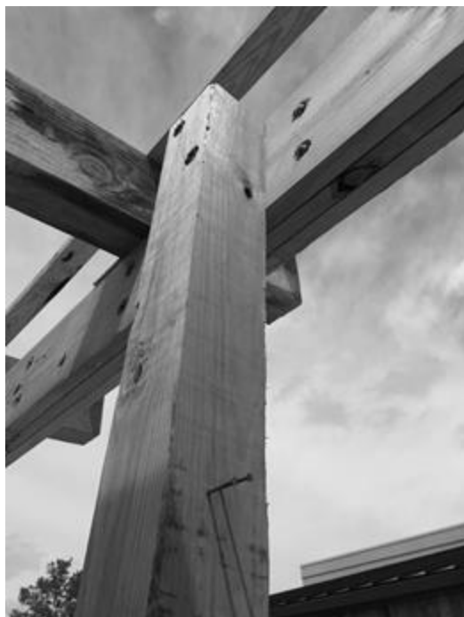
Figura 6 – detalhamento do telhado em construção.
