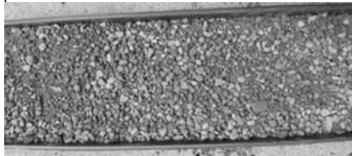
Figura 1.6 Colocou-se uma camada extra de pedra pela tamanha compactação do solo existente.
