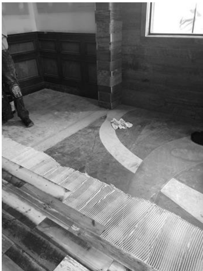
Figura 3 – colocação do piso.
