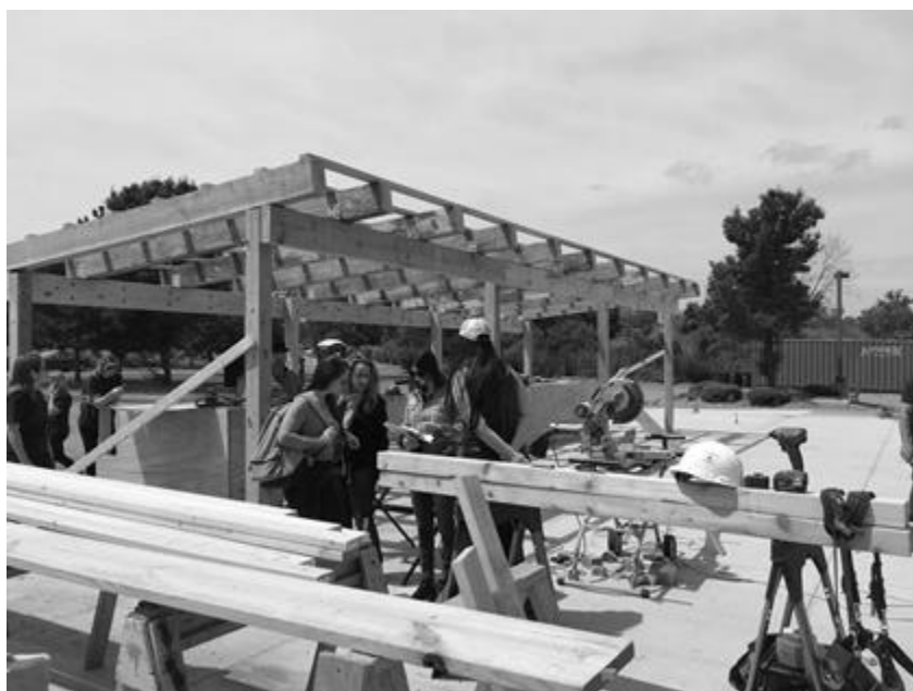
Figura 5 – construção do bar na parte externa.
