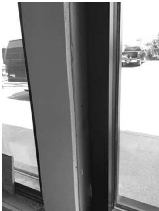
Figura 4 – vista do isolamento acústico e térmico.
