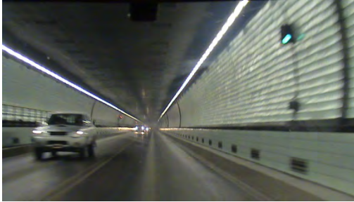
Túnel sob o Rio Paraná
