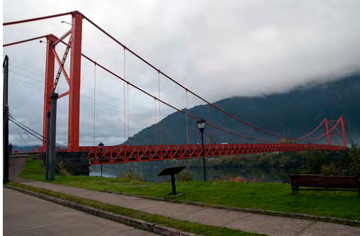
Ponte de Aysén
