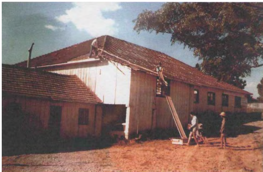
Figura 55 O velho Galpão do CTG Lalau Miranda, sendo demolido. Welci Nascimento - 1980
